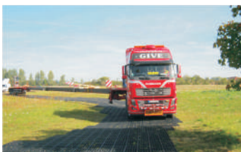
Dojazd do elektrowni wiatrowej
