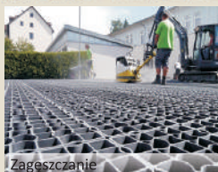
Zniwelowanie nawierzchni
